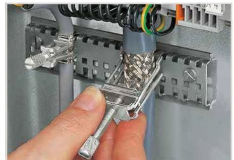
Pour démonter l'étrier de blindage, desserrer la vis moletée, puis retirer l'étrier en l'inclinant légèrement
