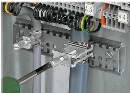
Après positionnement, il suffit de serrer la vis moletée. Couple recommandé de serrage de la vis 0,5 Nm
