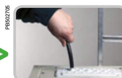
Tirer sur le câble ou le tube sur une distance d'environ 20 mm afin de le bloquer.
