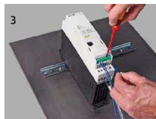
3 Effectuer le câblage du courant de commande.
