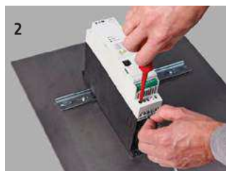
2 Raccorder les circuits principaux.
